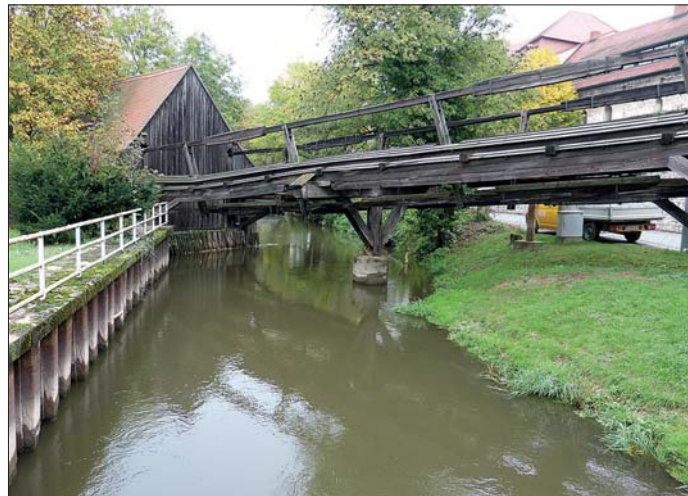
Abb. 15: Das 180 m lange funktionsfähige Kunstgestänge
