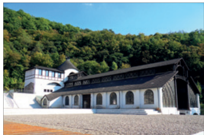
Abb. 13: Ein Kleinod der Industriearchitektur – die Gießhalle der Sayner Hütte in Bendorf
