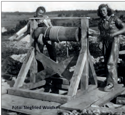
Abb. 3: Bei Förderbeginn waren nur Seilwinden vorhanden (Foto: Siegfried Woidke)
