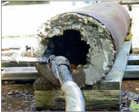
Abb. 3: Rohrreinigungssystem „Tornado“ von Kamat nutzt Höchstdruckwasserstrahlen
