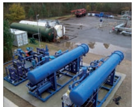
Abb. 4: ORC-Module mit 150 kW, 350 kW und 500 kW (von links nach rechts)
